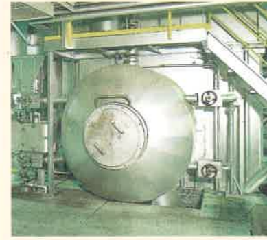
●ボイラドラム
